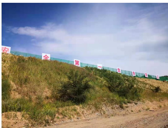
一采区挡渣墙
