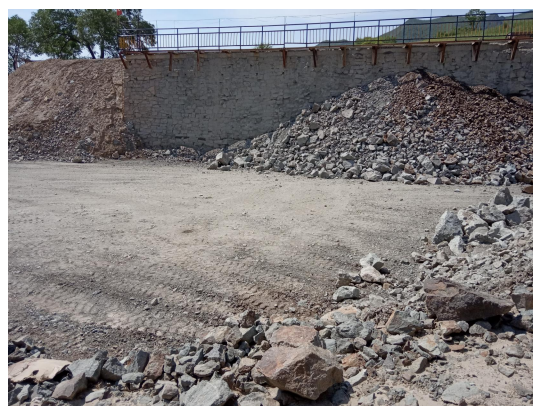
十线斜井废石场
