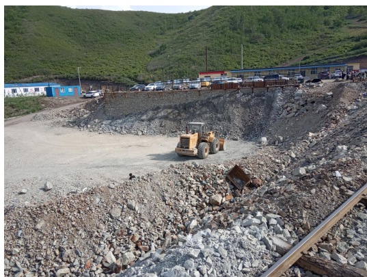
二采东区废石场
