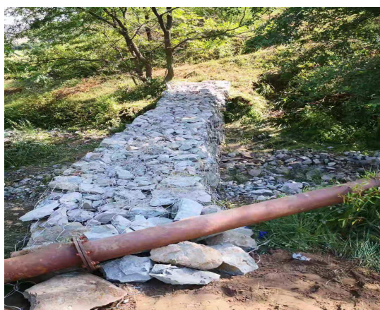
十线斜井挡渣墙
