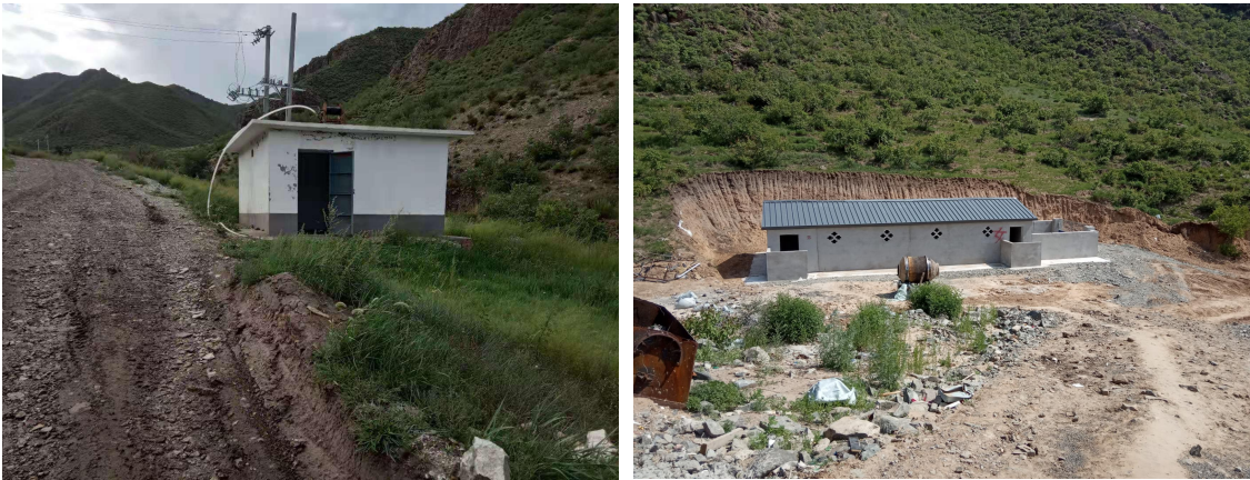
二采区供水井 采区旱厕
